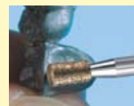
Repasado de zonas profundas de estructuras metálicas.
